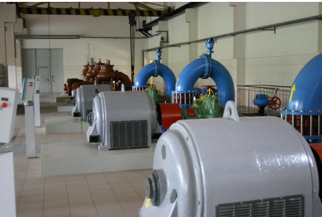
ZUW Dobczyce – pompownia wody uzdatnionej
