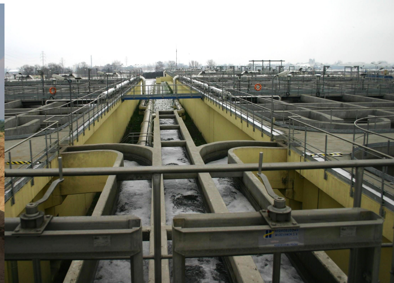
Nowoczesna oczyszczalnia ścieków Kraków- Płaszów. Reaktory biologiczne w trakcie eksploatacji
